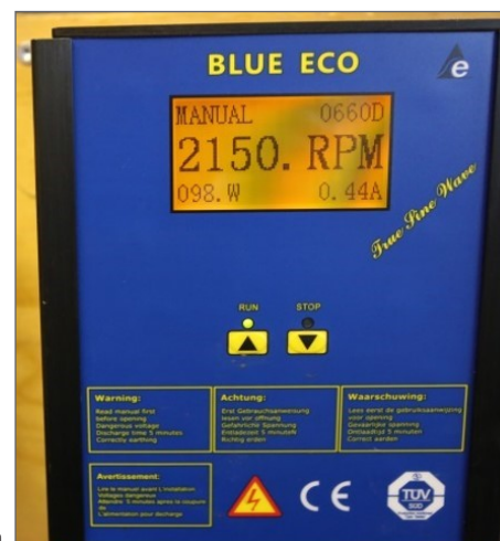
Reglage till filterpumpen.
