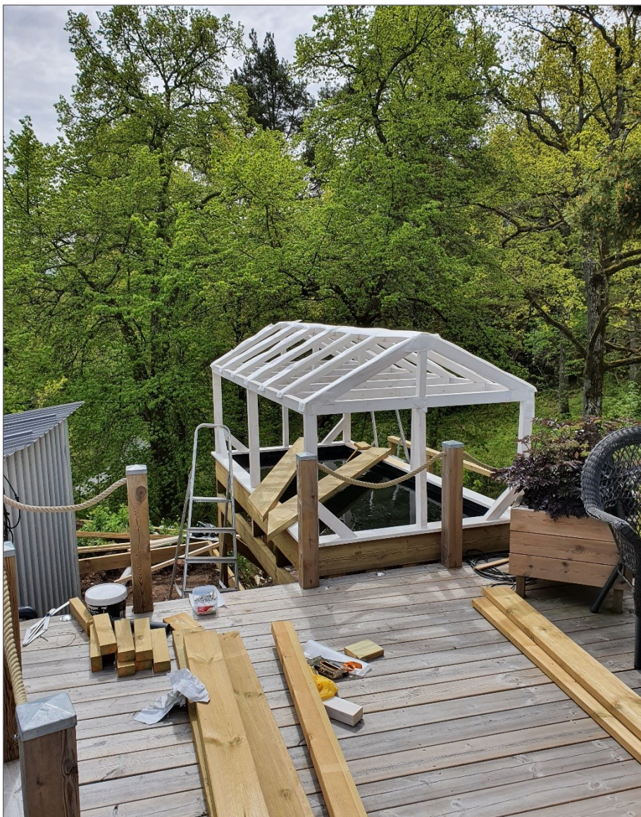
Här ser ni hur bygget har börjat ta form.
