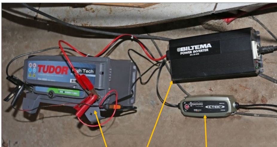
12-volts strömförsörjning; 12-voltsbatteri, transformator och batteriladdare.
