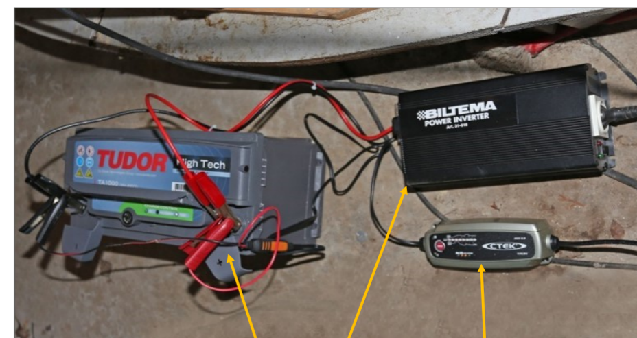
12-volts strömförsörjning; 12-voltsbatteri, transformator och batteriladdare.
