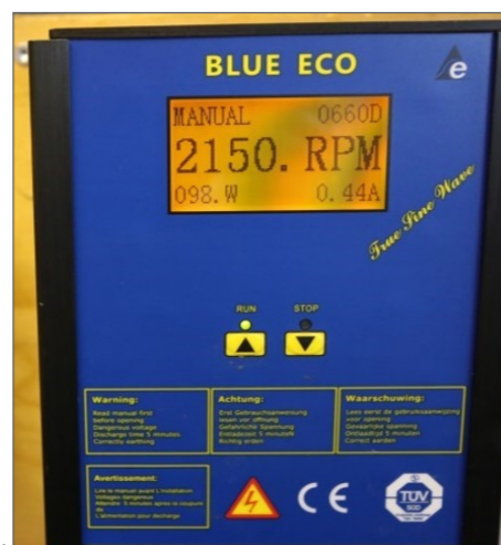
Reglage till filterpumpen.
