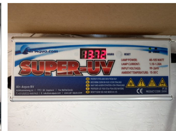
Styrenheten till Air-Agua med nedräkningen av rörets effektiva timmar
