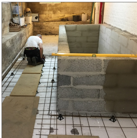
Dammen har putsats invändigt och övrigt golv förbereds för gjutning.
