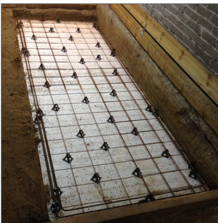
Redo för gjutning av dammens botten, isolering, armering och 10 cm med betong.
