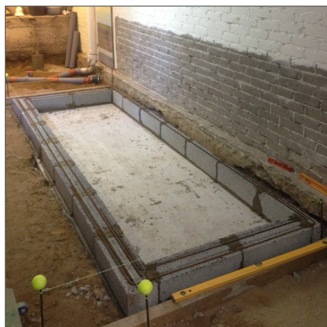
Botten i dammen är gjuten och första lagret murblock på plats.
