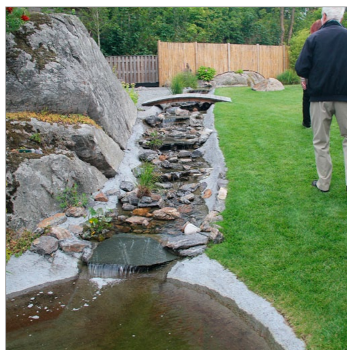
Bäcken som porlar nedför slänten är 13 meter lång och består av sprängsten och skifferplattor.
