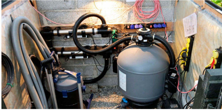
Det vinterbonade filterhuset bakom vattenfallet.
