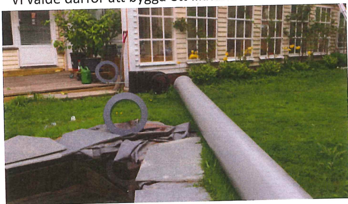
Bild från bygget av tunneln till innesdammen
