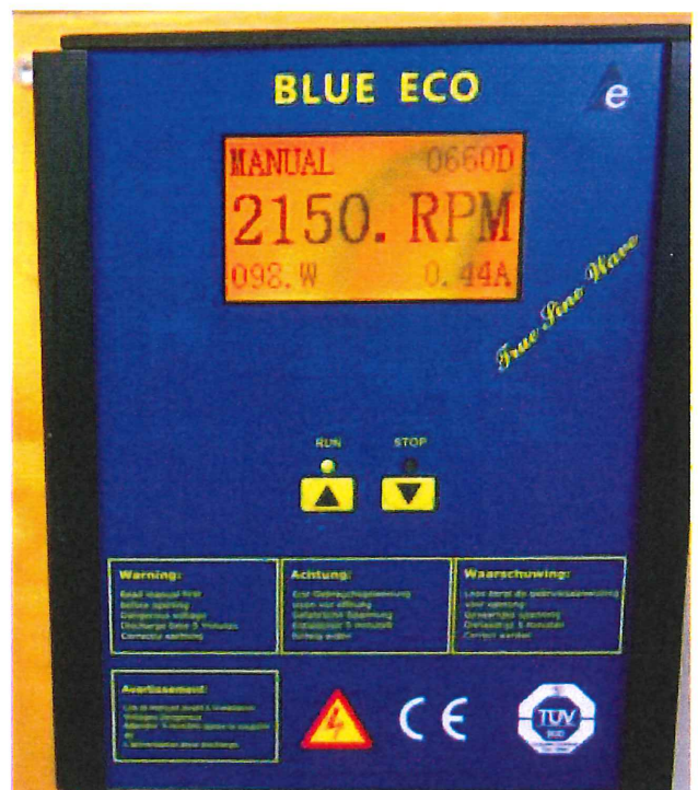
Reglage till filterpumpen
