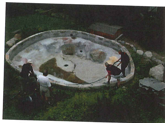
Finputsning inför läggning av dammduk
