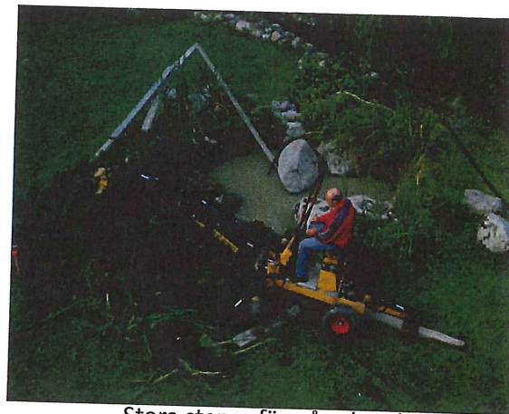
Stora stenar försvårade arbetet
