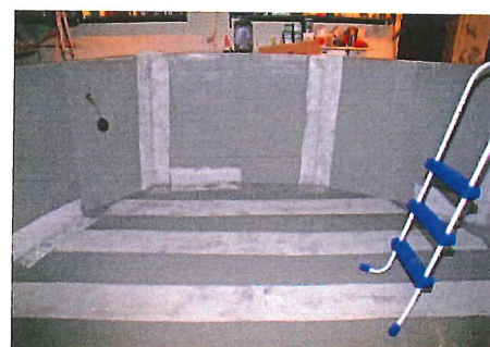
Glasfiberförstärkning i alla skarvar
