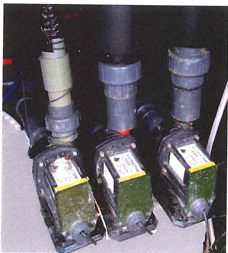
Pumpar med total kapacitet på 42 kbm.
