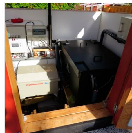
Filteranläggningen finns i en egen liten byggnad med höj- och sänkbart tak.
