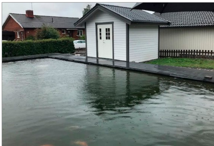
Filterhuset påminner om en klassisk badhytt eller strandbod vilket passar bra med tanke på dammens uppgift!
