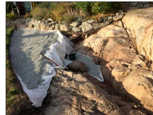
Bergsskrevan innan formen började byggas.
