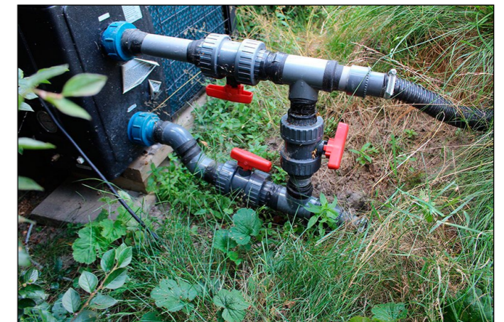
Väl gömd under ett litet tak. Anslutningar med "bypass" i serie med filteranläggningen. Utgången från värmepumpen bildar bäcken till dammen.
