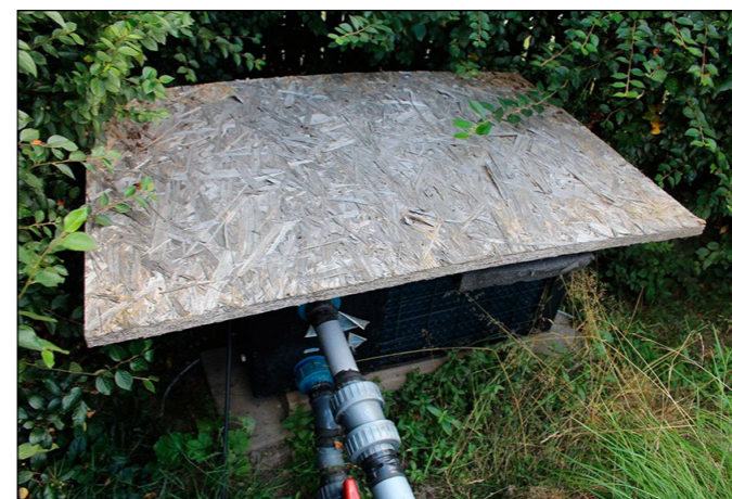
Väl gömd under ett litet tak. Anslutningar med "bypass" i serie med filteranläggningen. Utgången från värmepumpen bildar bäcken till dammen.
