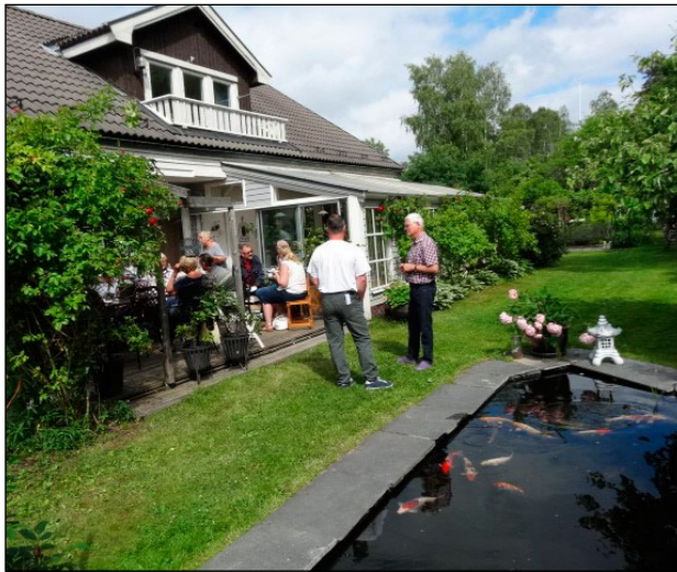
Från dammens hörn och in till uterummet ligger det underjordiska röret. Se bilderna nedan från byggtiden.
