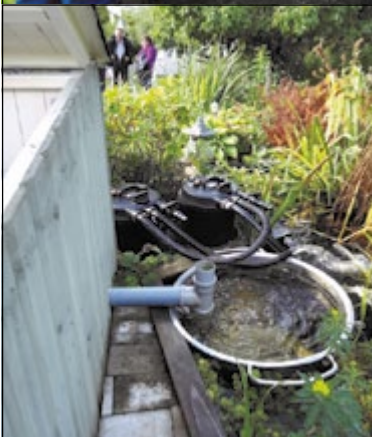
Bakom teknikhuset finns ytterligare en balja samt tryckfiltren.
