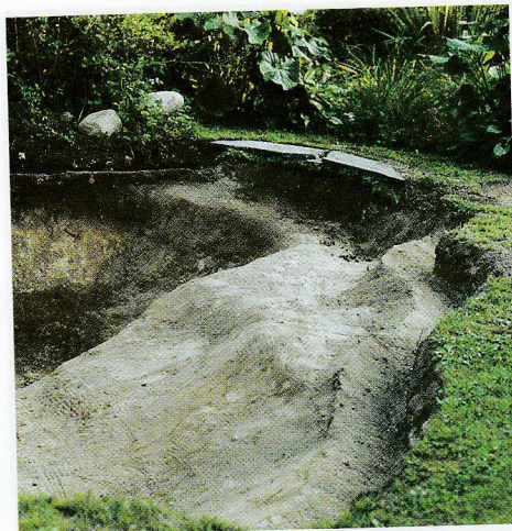
Gräv ut en hylla strax under den tänkta vattenytan och som lutar in mot dammkanten. Då går det lättare att dölja dammduken med sten eller torvblock.
